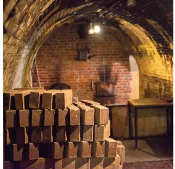
Blick in das Gewölbe des Ringofens.
