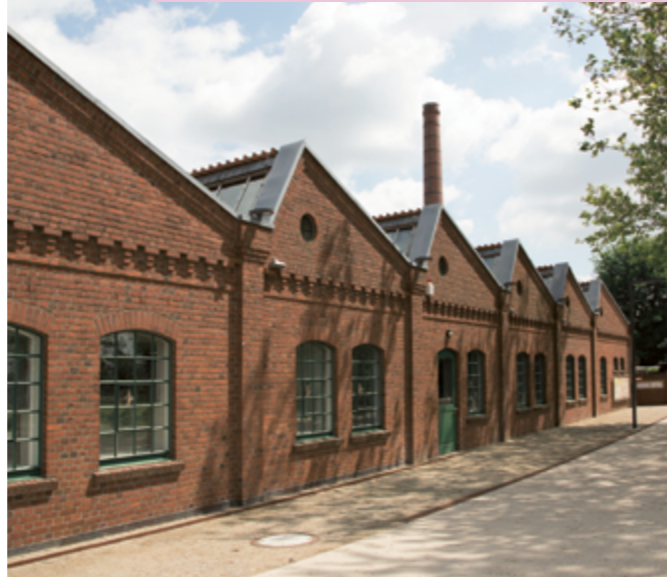
Direkt an der Aa liegt die Weberei mit ihren typischen Sheddächern.
