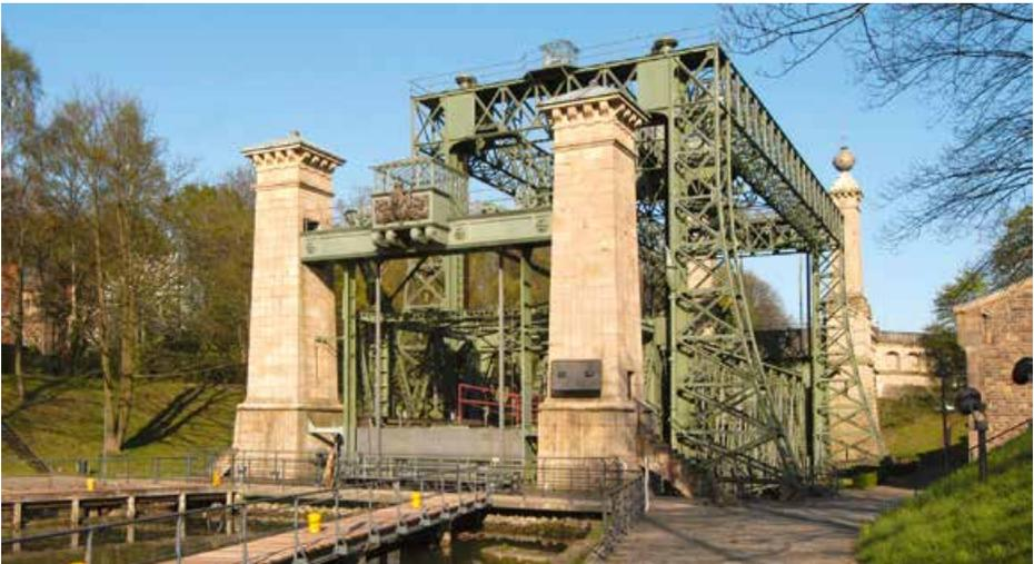
Das Schiffs-Hebe-Werk funktionierte wie ein **großer Aufzug**.
