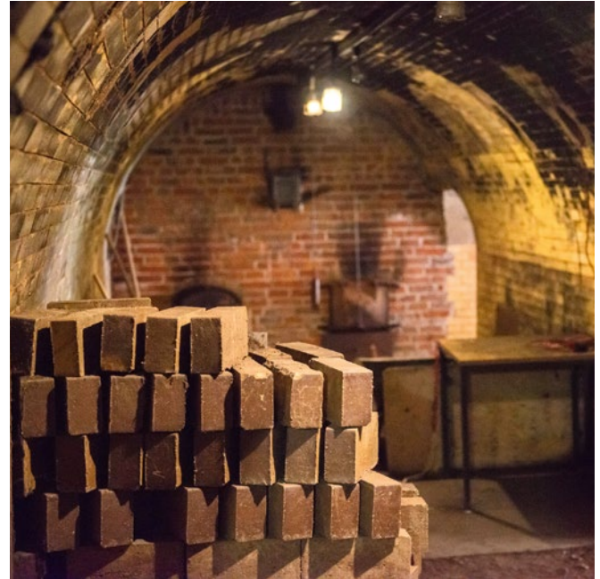
Blick in das Gewölbe des Ringofens.
